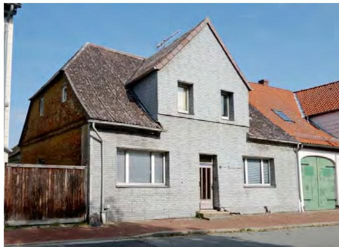
Abb. 3.3/3 Fulau 14: Materielle Verfremdungen an Dach und Fassade, Leerstand, hoher Sanierungsbedarf.
