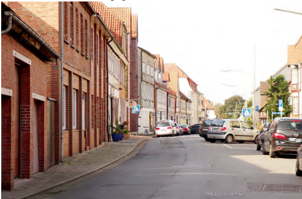
Abb. 3.2/1 Junkerstraße – Erhebliche Missstände, wie zu schmale Gehwege, Schäden an den Oberflächen und störende Prägung durch das Parken.
