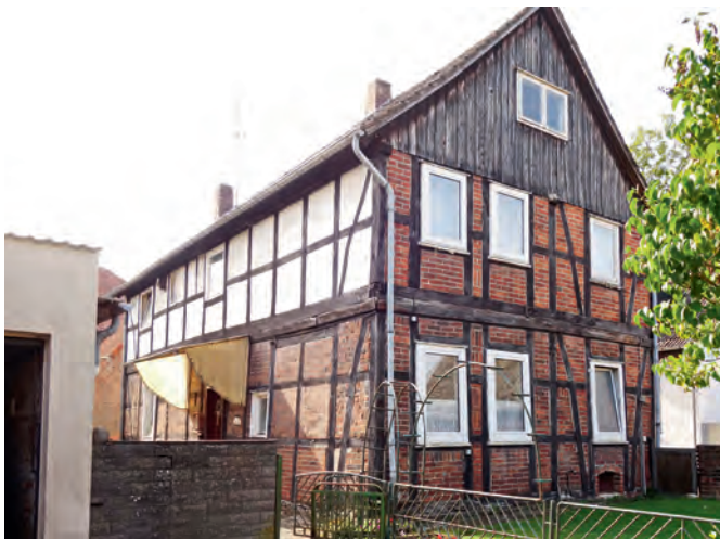
Abb. 5.4/2 Lyrastraße 1: hoher Sanierungsbedarf
