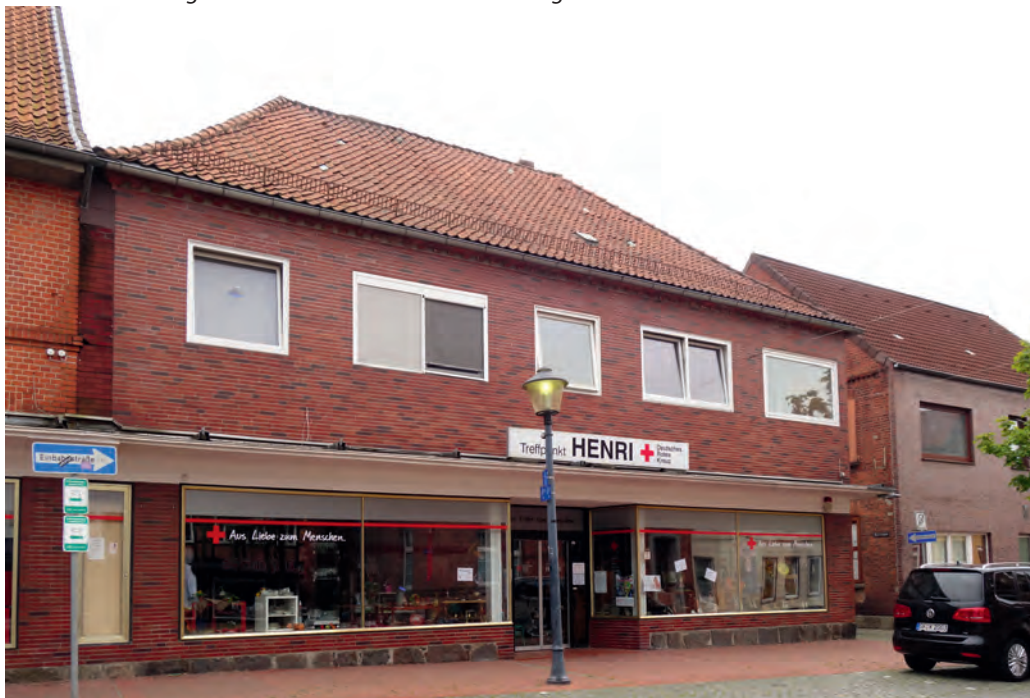
Abb. 3.4/1 Die Lange Straße 55-57 steht seit dem Umzug des DRKs in die Junkerstraße 24 ebenfalls leer.
