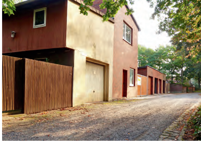
Abb. 5.4/4 Hofrückseiten am Hindenburgwall...
