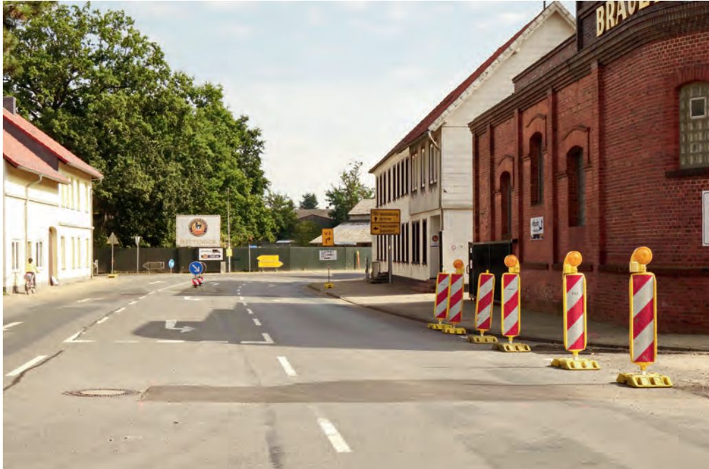
Abb. 2.4/1 Bundesstraße B 244, hier im Abschnitt Ernst-Stackmann-Straße
