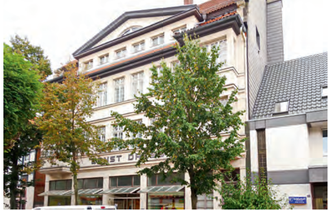
Abb. 2.712 Gebäude mit mehr als zwei Vollgeschossen, wie hier Lange Straße 33, sind die Ausnahme.
