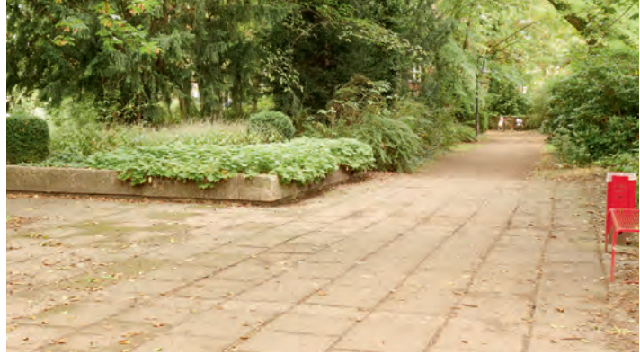
Abb. 5.3/1 Park am Junkerteich: Eine Teilsanierung der Oberflächen und Aufwertung des Grüns sind notwendig.
